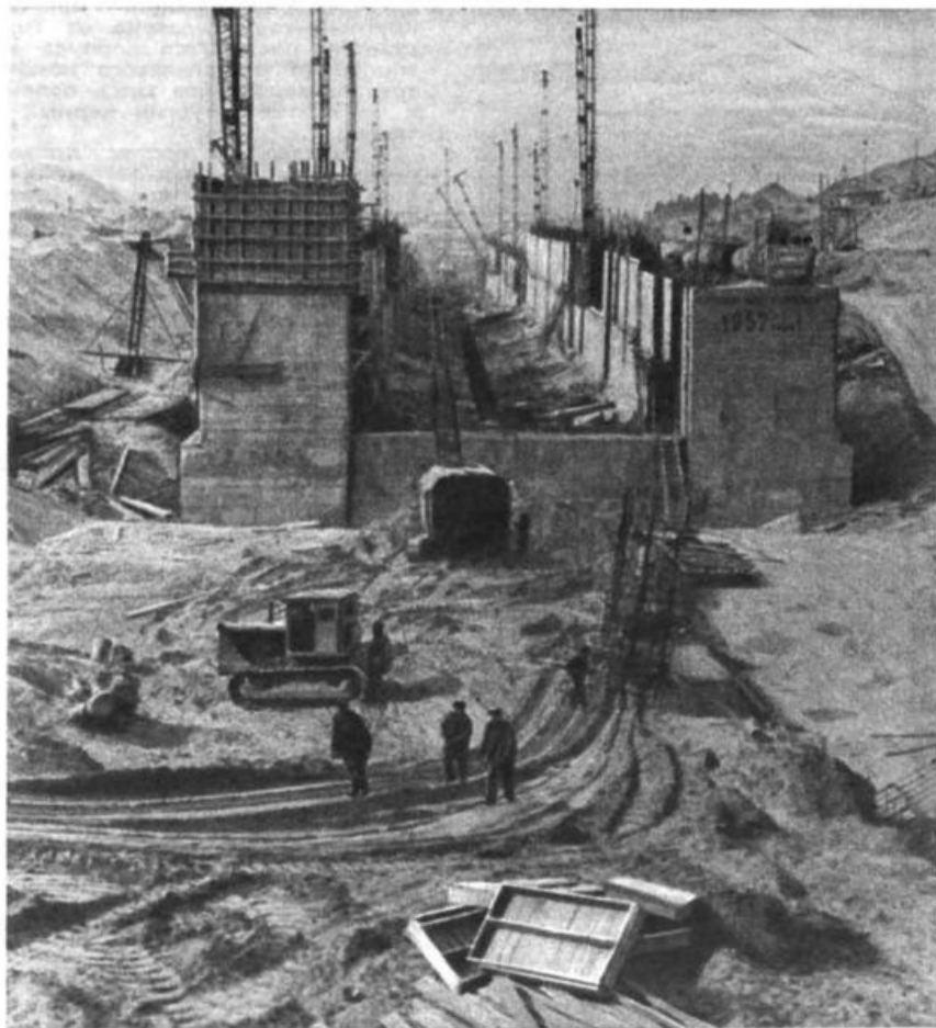
На строительстве Новосибирской ГЭС.
